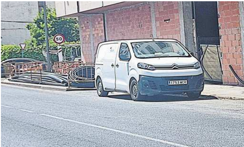
Una tubería en superficie garantizará el suministro a las viviendas mientras duren las obras
